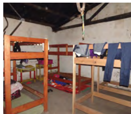
Alter Putz: Vor der Renovierung lebten die jungen Frauen in fensterlosen, kargen Kammern
